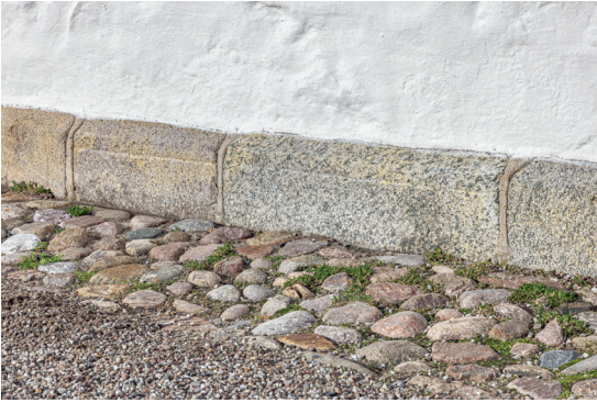
Fig. 8. Romansk granitsokkel på skibets sydside (s. 4491). Foto Arnold Mikkelsen 2024. – Romanesque granite foundation on the south side of the nave.
